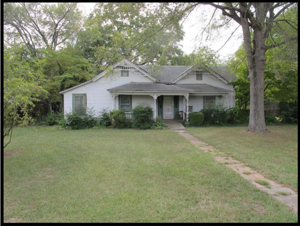
MK1338 – View of House, 106 S. Maxwell Av Looking West
